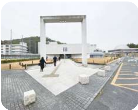
岡山県生涯学習センター外観
